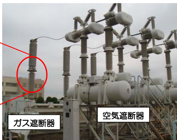
写真 研修用遮断器
