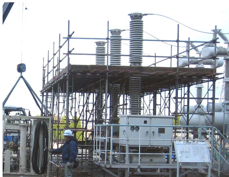
写真 遮断器保守作業の研修風景
