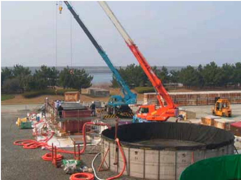
触媒再生工事の準備風景 白いシート上の水槽内で触媒を洗浄します
