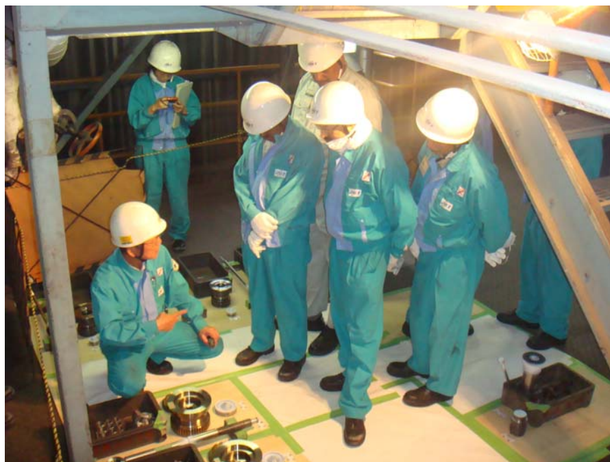
写真 定期点検中の火力発電所作業現場での研修状況
