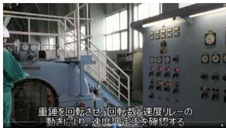
実習映像による調速装置特性試験の理解
